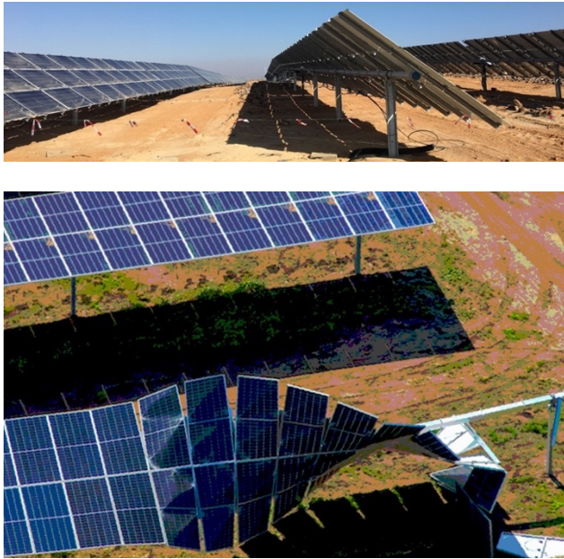
Figura 2. Campo de seguidores solares y efectos de la acción dinámica del viento.
